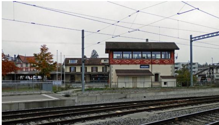
Das historische Stellwerk war von 1901 bis 2004 in Betrieb. (SRF)
