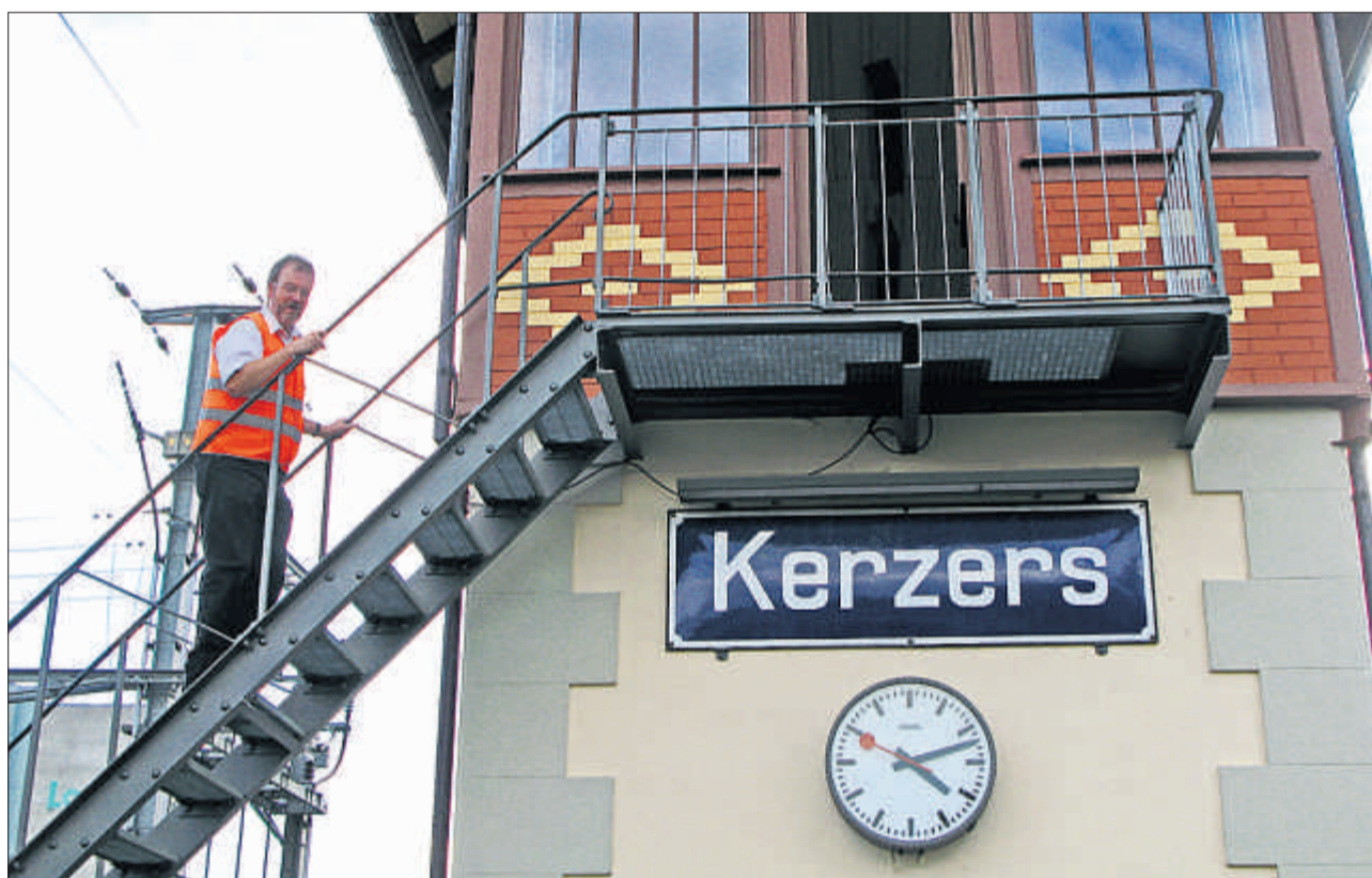
Beat Winterberger, Präsident des Stellwerks Kerzers, setzt sich seit über zehn Jahren für den Erhalt der historischen Anlage aus dem Jahr 1901 ein.
