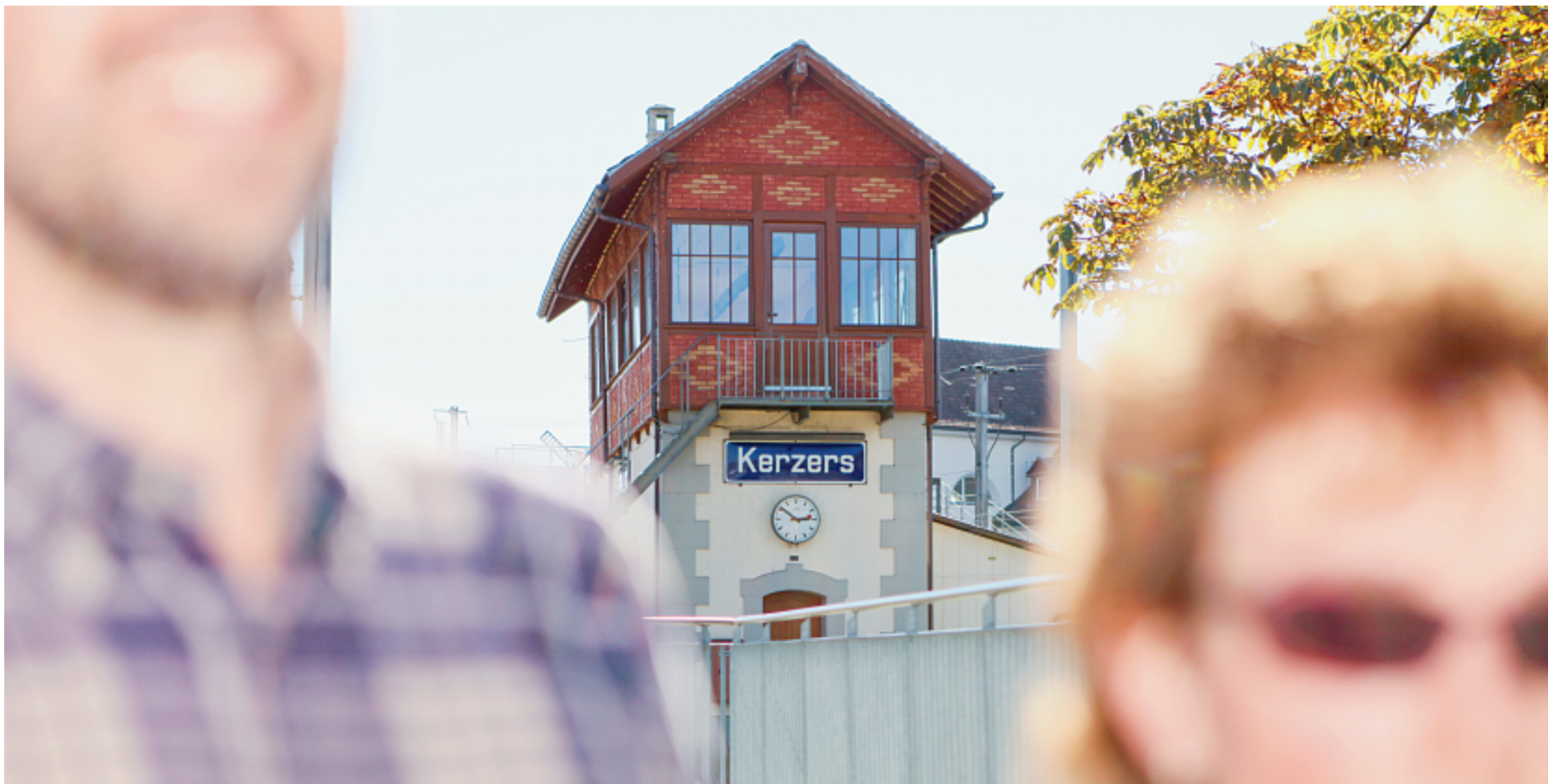
Ein schweizweit einmaliges industrielles Kulturgut: das über 100-jährige Stellwerk, das die SBB bei der Umstellung auf elektronische Fernsteuerung abreissen wollte.
